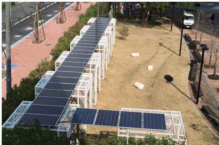
クールスポットに設置された大阪経済大学の自家消費型太陽光発電
