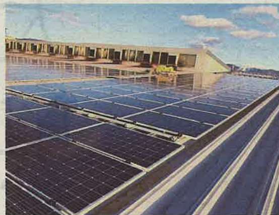
自家消費型太陽光発電の工場屋根施工事例 滋賀県
